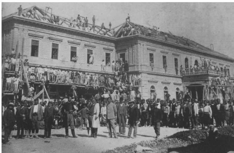
Izgradnja Vladinog doma
